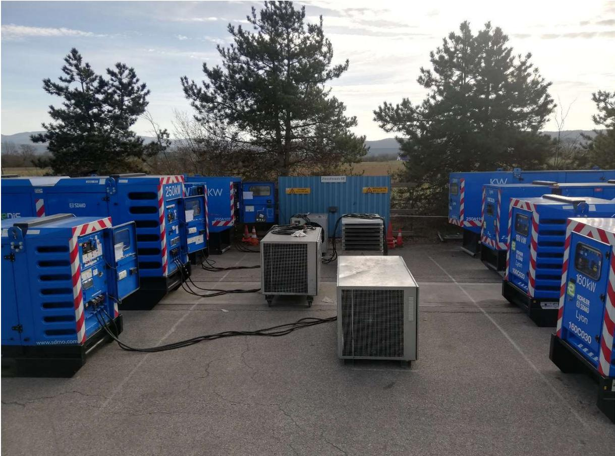
**Illustration d'une zone d'essais de groupes électrogènes**
